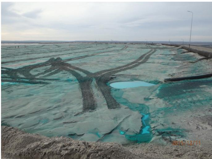
**Specjalna deszczownica, emulsja asfaltowa i drogi pokryte szczególnym kruszywem – w taki sposób KGHM zmniejsza uciążliwość Żelaznego Mostu.**
