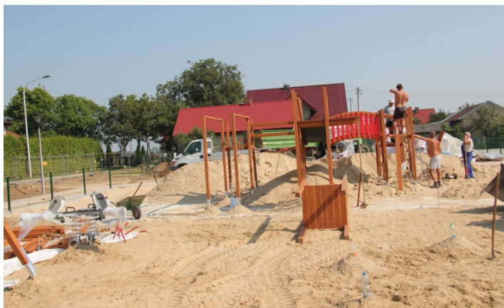
W trakcie montażu jest duży plac zabaw
